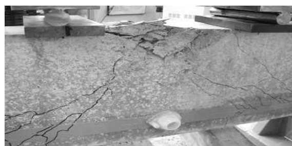
Fig.9 下補強 破壊様相
