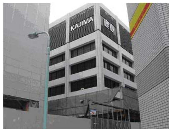
写真1 解体中の鹿島建設旧本社ビル
