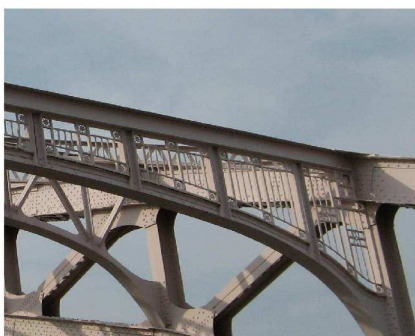
写真2 十三橋の端スパン外側のポータル装飾（平成19年8月撮影）
