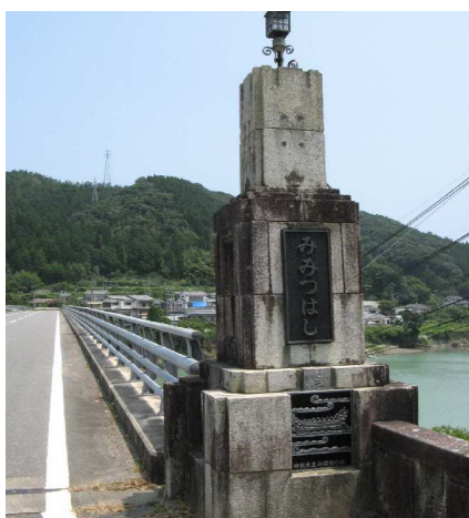
写真1 美々津橋親柱現況（平成19年8月撮影）
