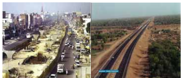
写真 1 高架橋工事 (Panipat) 写真 2 Ahmedad Expressway 「参考文献」
