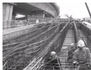
図-5 PC 鋼より線使用現場
