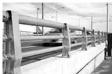
図-9 橋梁用車両防護柵(イメージ)
