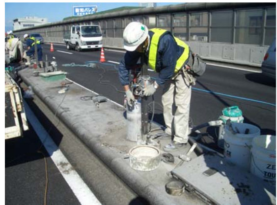
Fig. 4 ダイヤモンドカッターによる残置支柱撤去工事
