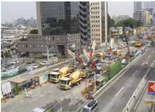
写真7 コンクリート打設時ポンプ車配置状況
