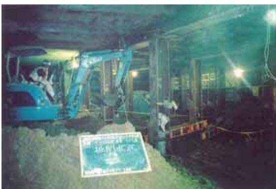
写真4 パイプルーフ内掘削状況
