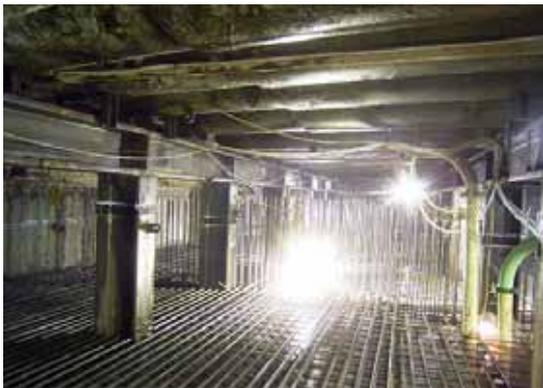
写真6 パイプルーフ内コンクリート打設箇所
