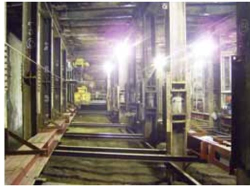
写真5 支柱、一次切梁、一次掘削完了
