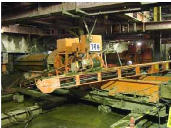
写真1 パイルーフ施工状況（上部）
