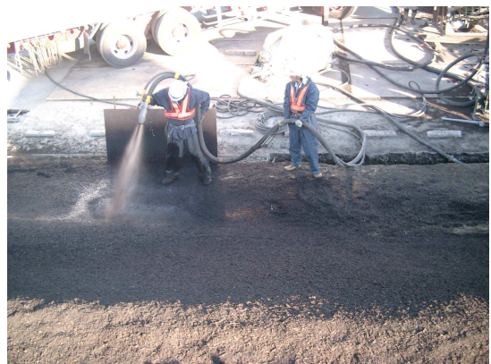
写真— 1 緑化基盤材の吹付け状況
