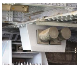
写真-1 永代橋 落橋防止装置
