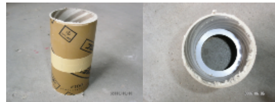
写真-1 紙製パイプ型枠
