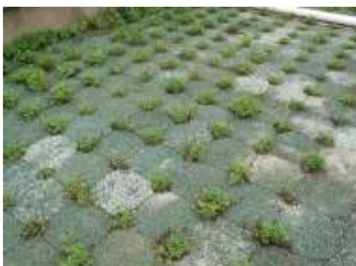
写真—13 護岸浸透ろ過ブロック
