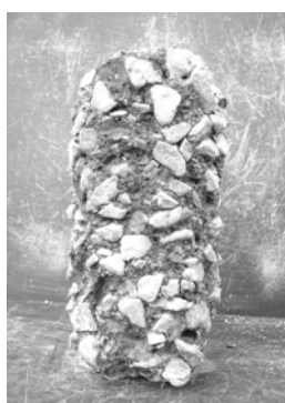
普通コンクリート
