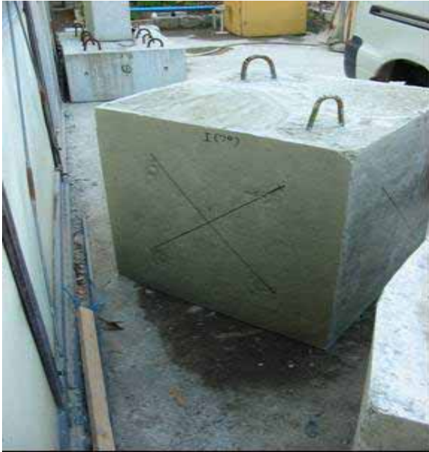
写真-4 コンクリートの表面状況 (廃木ボード 面)
