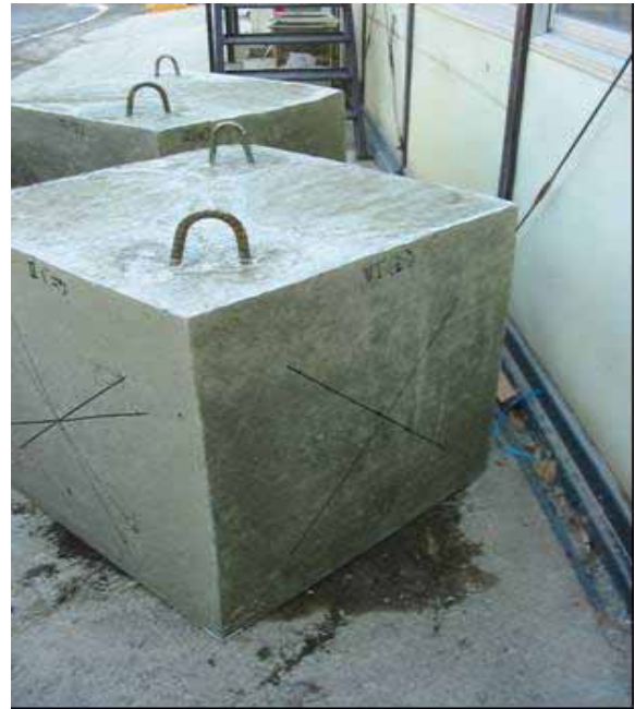
写真-6 コンクリートの表面状況 (合板 面)
