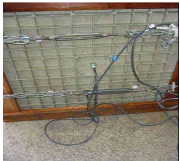
写真-2 側圧計の設置状況
