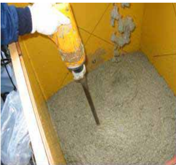
写真 - 3 コンクリートの打設状況
