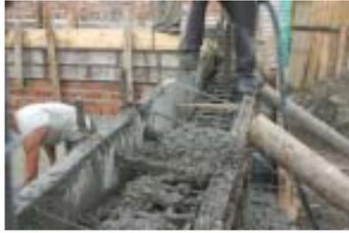
写真2 コンクリートを採取した鉄筋コンクリート造 A の打設状況
