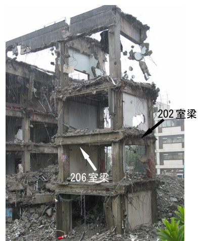
写真-1 吊り降ろし直前の梁試験体
