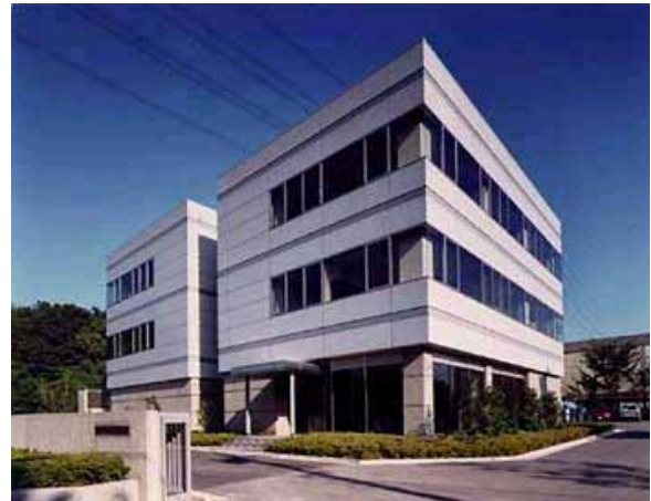
写真1 在来棟(右前)と免震棟(左奥)
