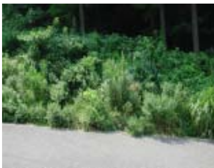
2005年8月 自然法面
