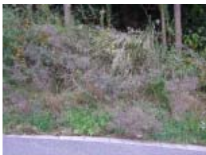
2005年2月 自然法面 自然法面写真
