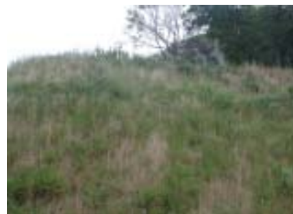
2004年8月 緑化法面
