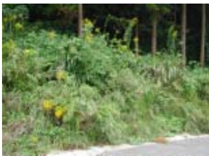
2004年8月 自然法面
