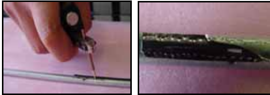
写真6-2 電気融着作業 写真6-3 電気融着状況
