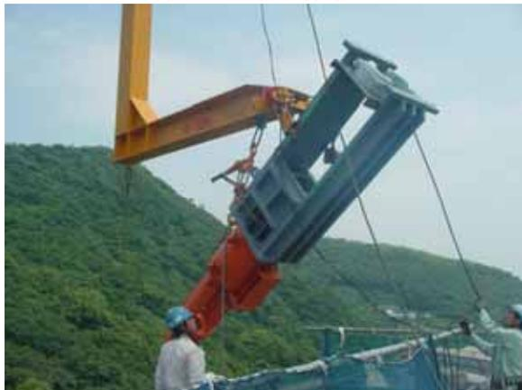
写真 3 特殊天秤による引込み設備の取扱い
