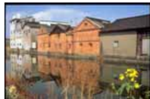
(写真-4) 柳川城堀地区
