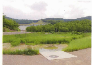
写真-4 自然地形を利用した洪水調整池
