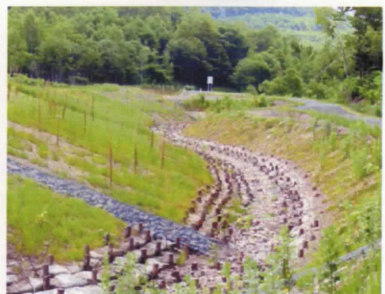
写真-5 現地発生材を用いた護岸
