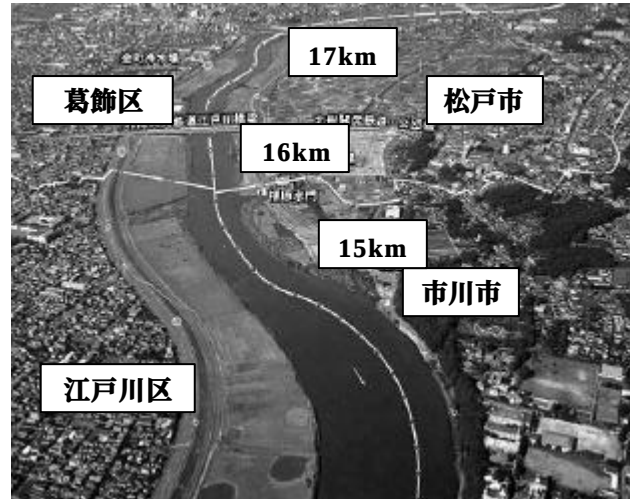
写真 - 1 対象地域 15km～17km 付近 (河川事務所からの航空写真より)
