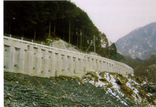
写真1 親杭パネル壁の全景
