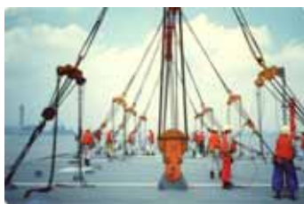
図—1 1 ステー取付け作業
