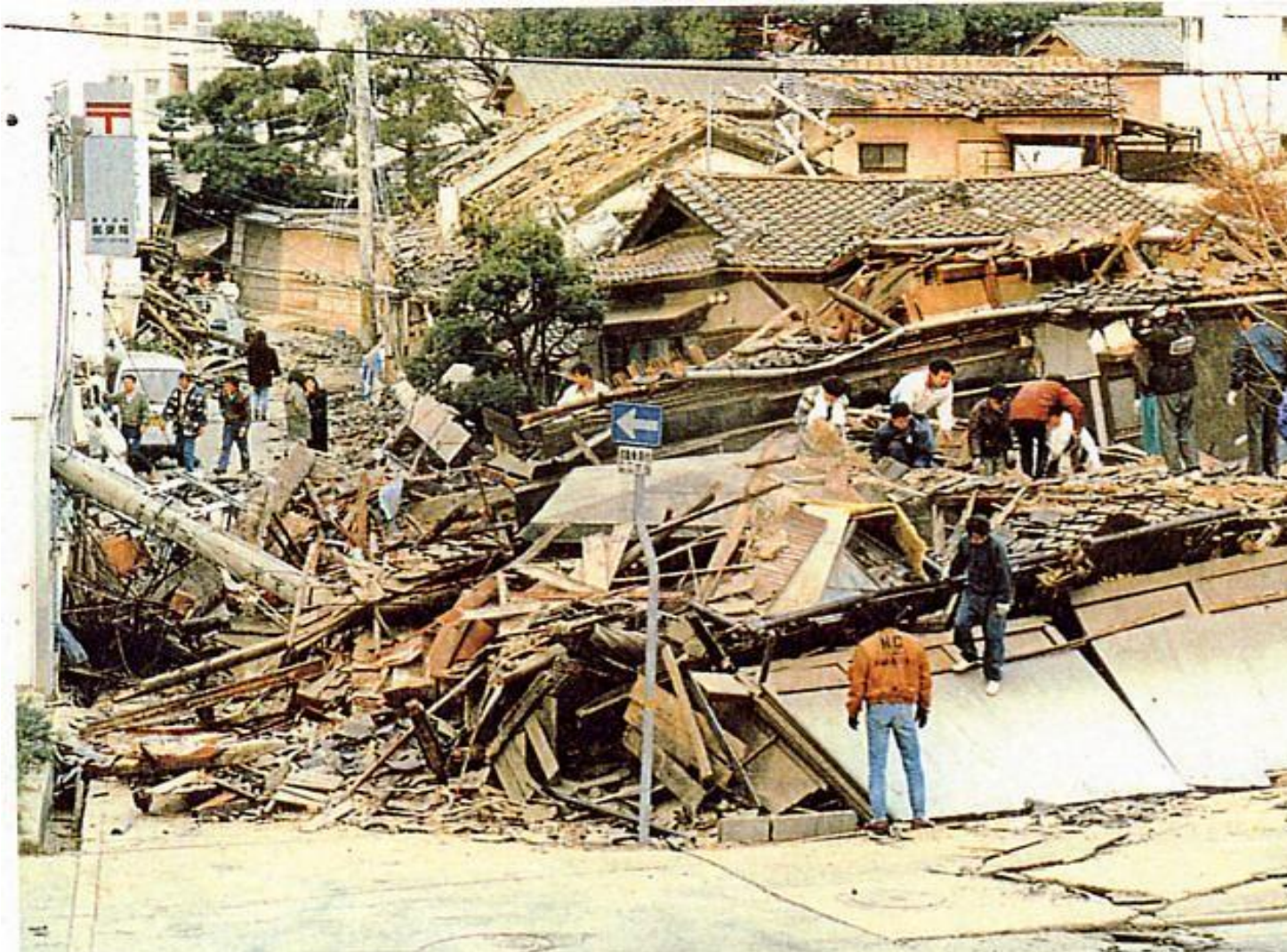
倒壊した家屋が道路をふさいでいる(神戸市提供)
