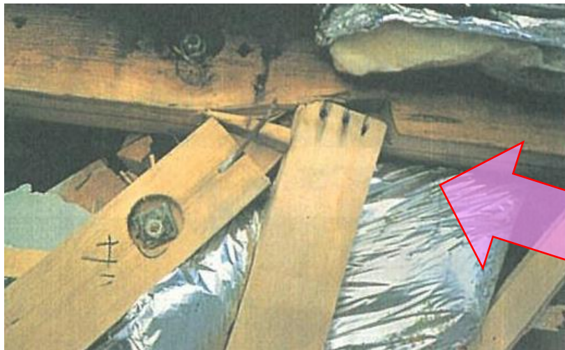
結合部の不良による倒壊(神戸市提供)
