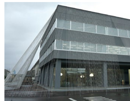
「CABKOMA ストランドロッド」を使用し、耐震補強をした旧本社「ファープ」
