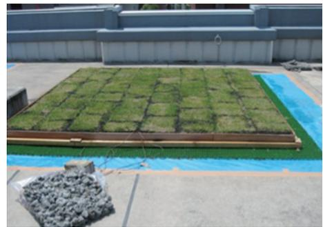
写真2 基盤材の上に土を盛り柴を植生した状態
