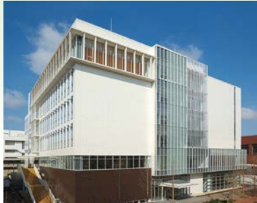
生産工学部の基本ビジョンであるものづくり精神の拠点となる、創設 60 周年記念棟 39 号館が完成。
