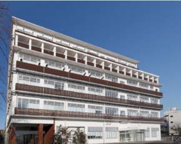
環境安全工学科、創生デザイン学科の拠点棟 40 号館が完成。大学としては最大規模の LINC5 など、研究施設の充実を計りました。
