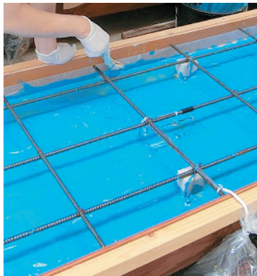
図1 エポキシ樹脂接着剤の塗布
