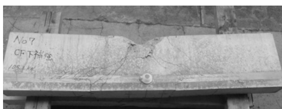
Fig.8b 下側補強コンクリートの破壊様相
