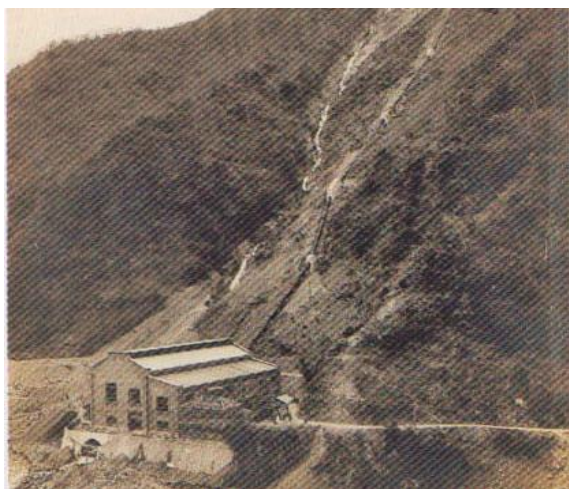
図7 旧落合発電所（東亜建設工業百年史より）
