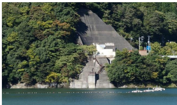
図8 現在の落合発電所
