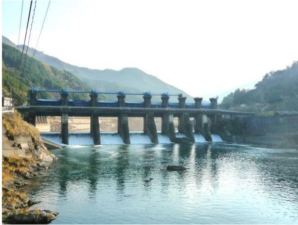
写真-1 撤去前の荒瀬ダム
