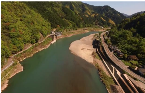
写真-2 荒瀬ダム撤去後の状況
