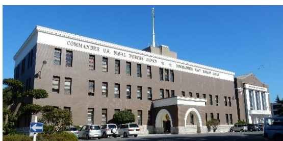
写真1 旧横須賀鎮守府庁舎
