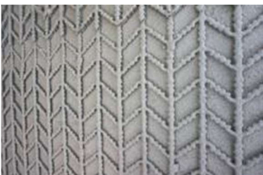
(e) PCM吹付け途中の格子筋
