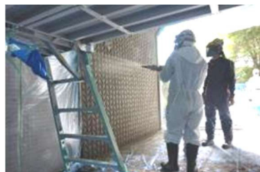
(d) PCMの吹付け作業
