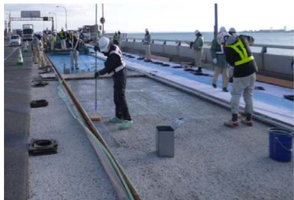
写真-2 2種類の接着剤塗布状況
