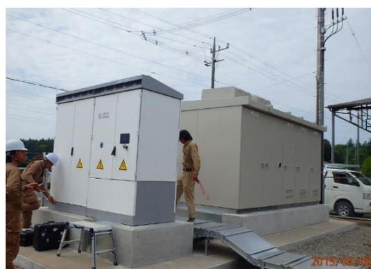
図3 小滝 SMAパワコンと日立高圧受電設備
