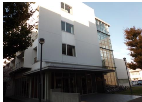
写真1 対象建物南側写真
