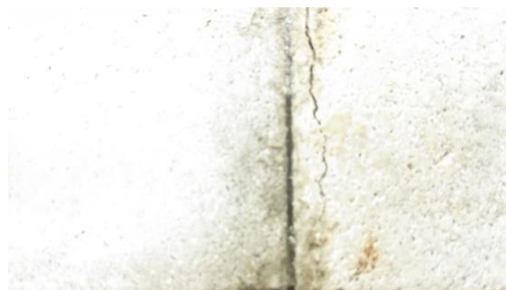
図1 せん断破壊を起こした供試体
