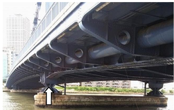
写真4 桁受け支承の補強（清洲橋）
