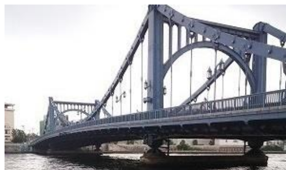
写真1 清洲橋（撮影日：2015年9月6日）
