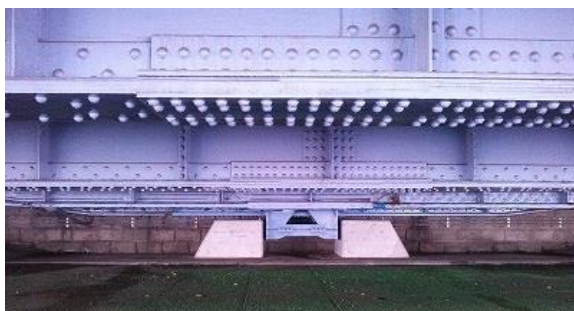
写真6 橋台部変位制限装置（永代橋）
