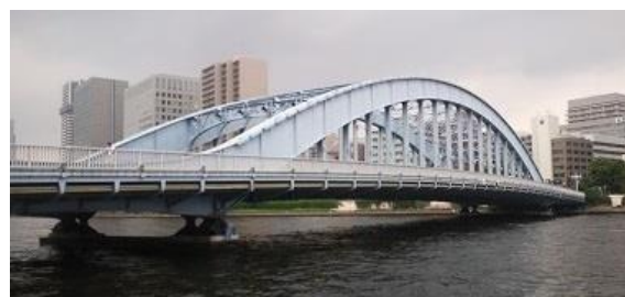
写真2 永代橋（撮影日：2015年9月6日）
