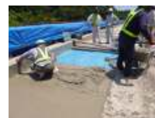
コンクリート打込み
