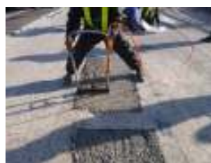
床版部分補修
