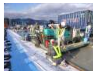
コンクリート打設
