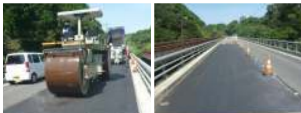
アスファルト舗装
