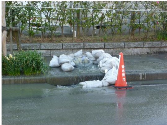
写真-4 習志野市の下水噴出状況
