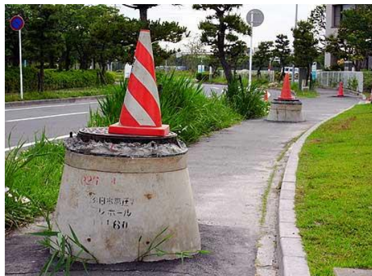
写真-5 浦安市(入船地区)のマンホール浮上状況
