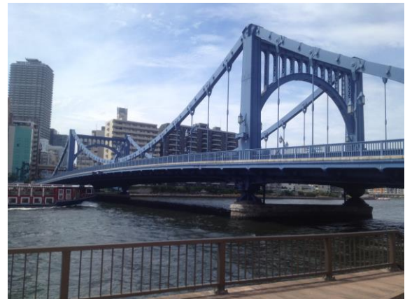
写真-1 清洲橋全景（撮影日：2013年5月19日）
