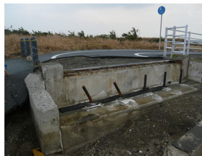
写真-1 自転車道橋台(調査点 3)
