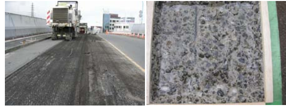
(1) アスファルト舗装撤去 (2) 既設床板切削
