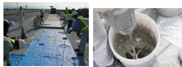
(7) 接着剤塗布工 (高耐久型エポキシ樹脂系) (8) 補修材製造工
