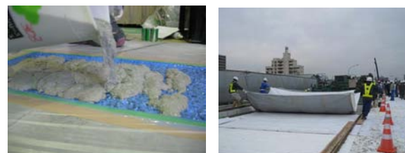
(9) 補修材打込み (10) 養生工
