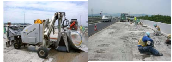
(3) 脆弱部除去(WJによる) (4) 脆弱部除去(人力)
