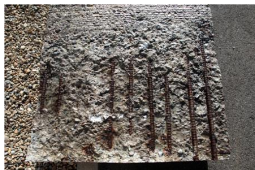
写真-1 施工前の供試体表面
