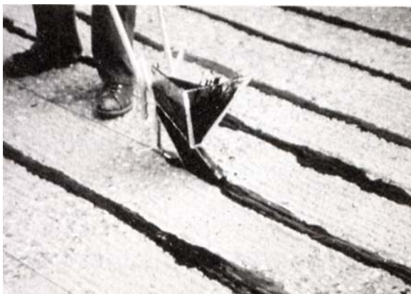
写真5 溝式ノンオーバーレイ方式
