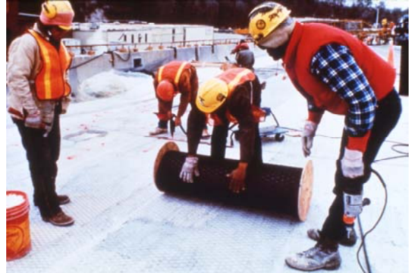
写真6 チタンメッシュ方式の陽極設置状況
