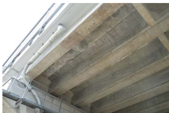
写真8 凍結防止剤散布地域のPCT桁橋梁
