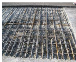
写真-2 WJによるハツリ後
