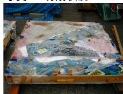
写真-6 床版給水状態
