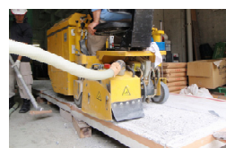
写真-4 切削状況
