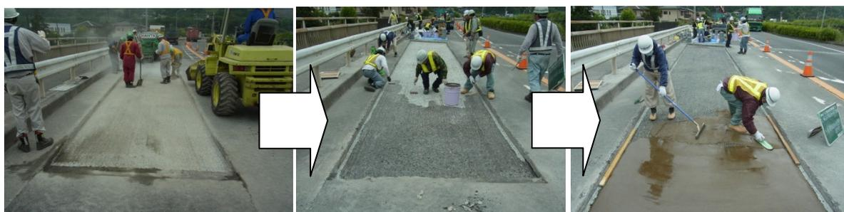
写真-3 路面切削後 清掃      写真-4 MMA樹脂プライマー塗布      写真-5 MMA樹脂モルタル施工
