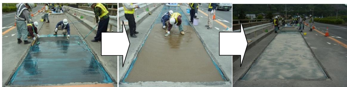
写真-6 CFSSの施工      写真-7 保護モルタルの施工      写真-8 砂接着層の施工
