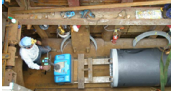
図1 PIP工法による管更新
