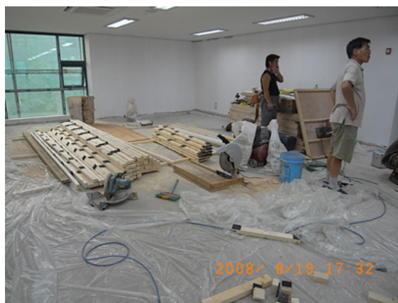
写真7 新當3洞自治センター リモデリング工事
